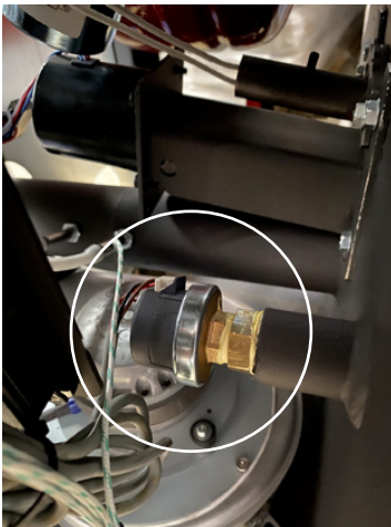
Wasserdrucksensor
