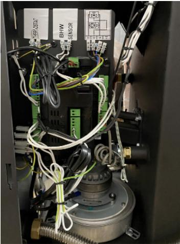
Hauptplatine mit Anschluss des Pufferfühlers (BHW Sensor)
