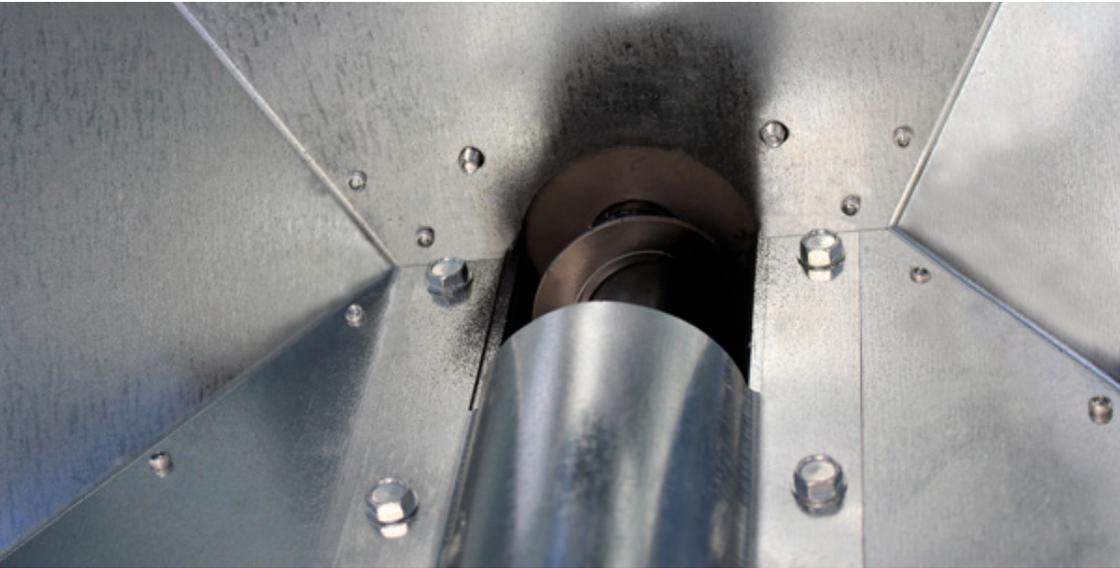
Förderschnecke im inneren des Tanks. Hier werden die Pellets entnommen.
