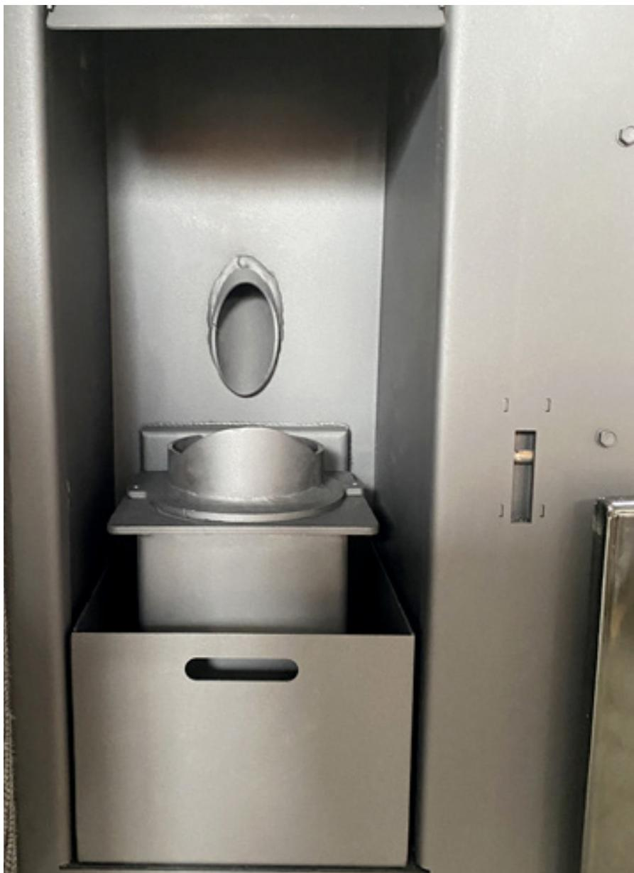
Brennkammer mit Brenner und Aschekasten.
